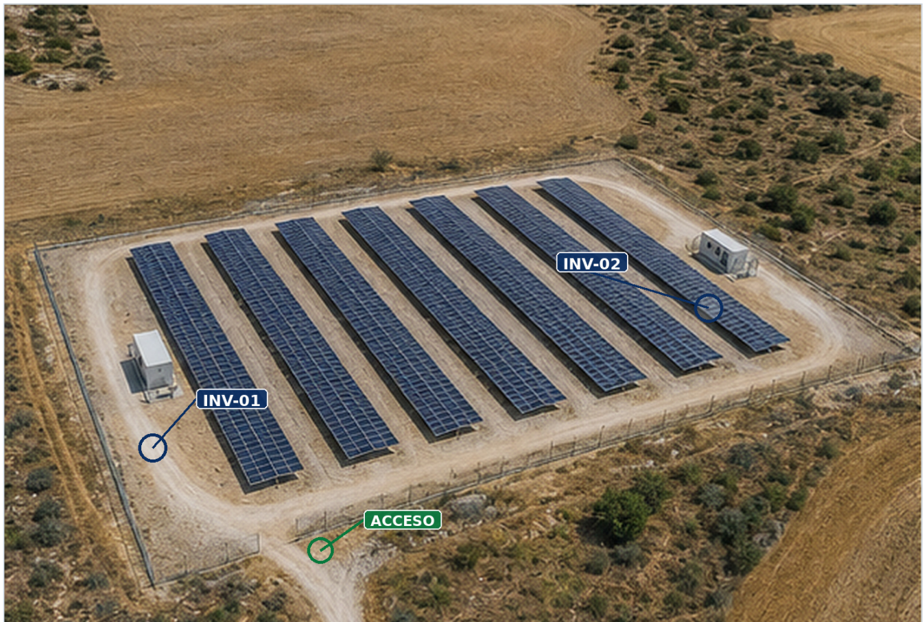
Figura 1. Vista oblicua de la planta simulada, aislada entre parcelas agrícolas y monte bajo. Se identifican dos estaciones de inversores y el acceso por camino rural.
