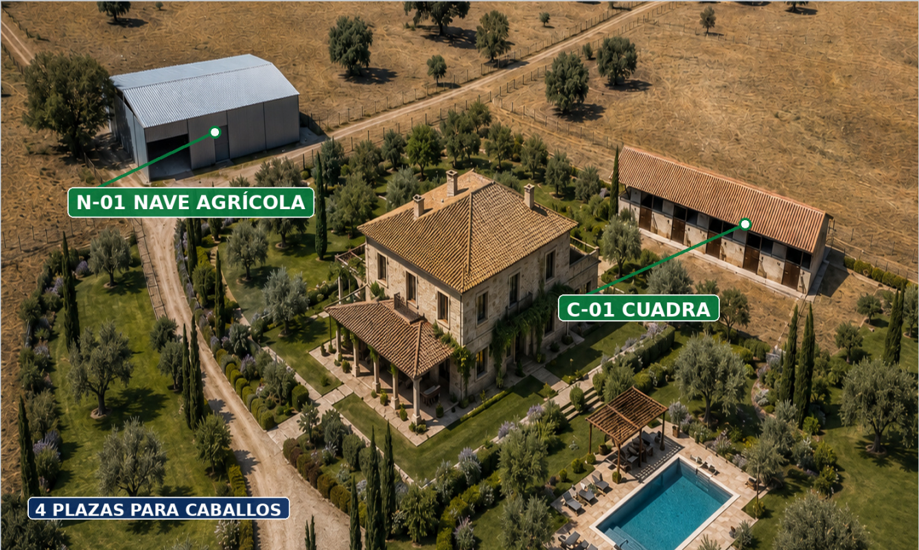
Figura 4. Vista de referencia de C-01 y N-01. Se documentan por separado las envolventes exteriores; los caballos, aperos, maquinaria y materiales almacenados no forman parte del inventario aéreo.
